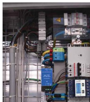
▲ Trasformatori amperometrici installati direttamente nella canaletta dei cavi
