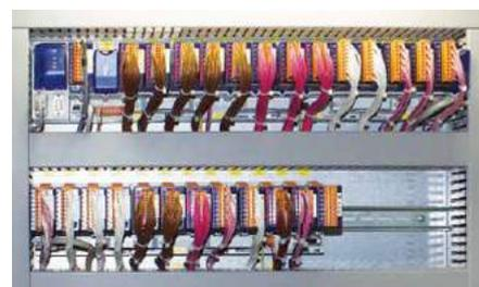
Montaggio su file multiple del PCD3 nel quadro elettrico
