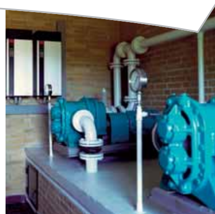
Il funzionamento del compressore in modalità flessibile, anche al di sopra della velocità nominale, e un'elevata coppia di spunto per gli avviamenti, consentono un migliore controllo e maggiori risparmi.
